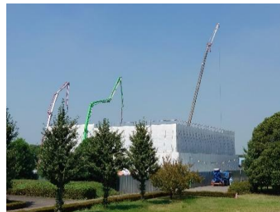
WLTP試験に対応した試験施設の 建設工事
