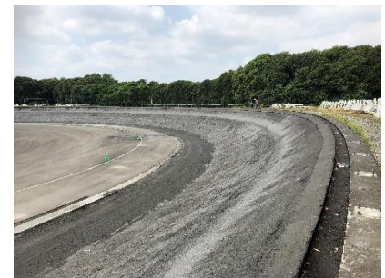
走行試験路の改修
